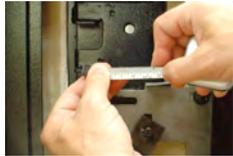
1. Mesurez l'épaisseur de la porte (distance entre la surface de montage de la serrure et la surface de montage clavier. Ajoutez  $\frac{3}{4}$ " (19 mm), et coupez la tige en aluminium à cette longueur.
