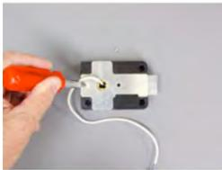
2. Suelte los dos tornillos que sujetan la placa que cubre la pieza de arrastre del cuerpo de la cerradura.
