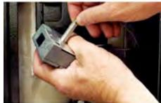
3. Cuando deslice la última parte del cable a través de la ranura del eje, coloque el cable en el cilindro del cuerpo de la cerradura. El eje y el cilindro están preparados para un correcto ajuste.
