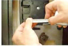
1. Mida el grosor de la puerta de la caja fuerte (distancia desde la superficie de montaje de la cerradura a la superficie de montaje del teclado). Añada 19 mm a la medida tomada, y corte el eje a la longitud resultante.
